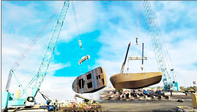
عملیات رول‌آپ (برگرداندن سازه) شناور نوساز طناب‌گیر در گروه طراحی، ساخت و تعمیر شناورهای کوچک ایزوایکو با موفقیت کامل انجام شد.
